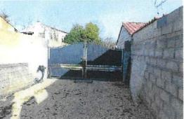
Présence d'une arche avec toiture en état d'usage. Présence d'un second portail qui n'a pas pu être testé, sale et présence de rouille.
