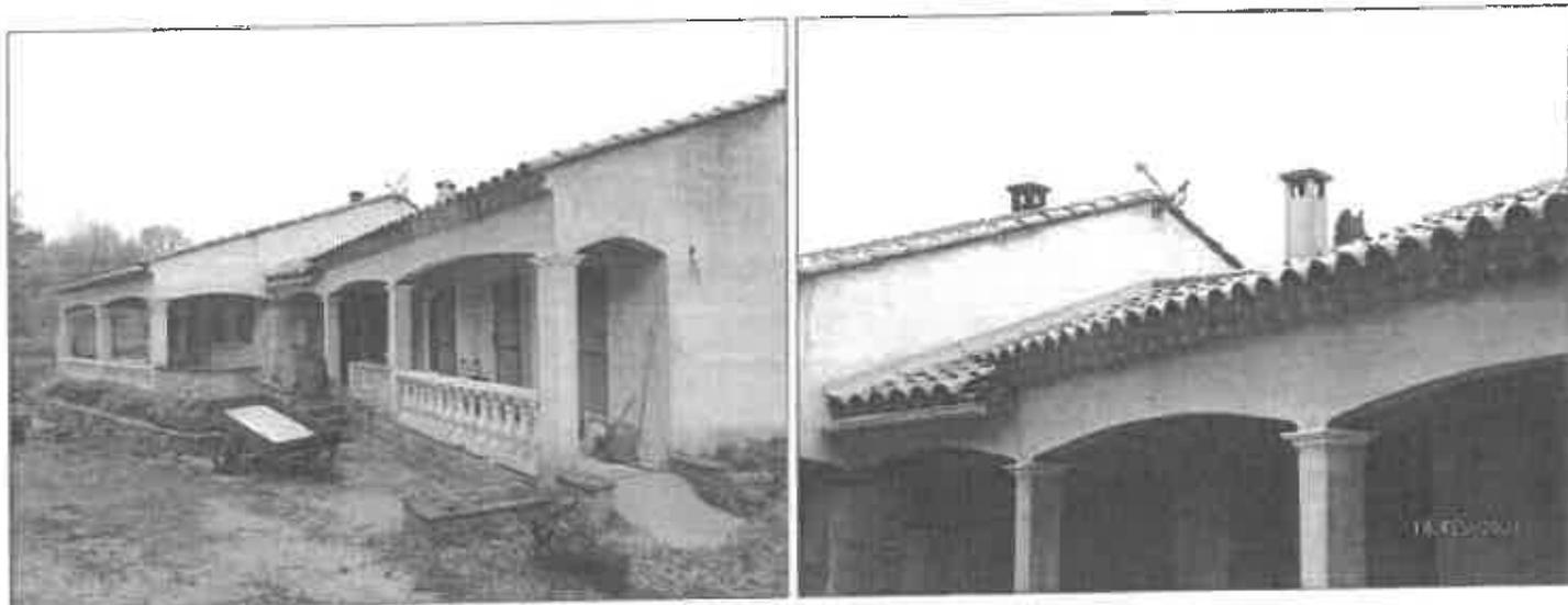
Les façades sont simplement recouvertes d'un ciment lissé ou encore resté en l'état de parpaings bruts.
