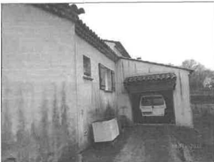
Il n'y a pas de chéneau ni de descente pluviale mais les pattes de fixation sont présentes au-dessus des rangs de génoises.
