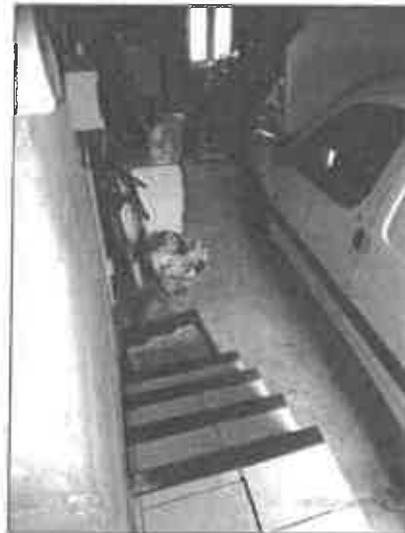
Ce garage est resté à l'état brut de parpaings, dalle ciment lissée sous toiture et tuiles mécaniques modernes.
