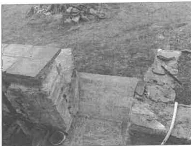
Les murets de part et d'autre ne sont pas terminés. Les maçonneries sont inachevées ainsi que l'habillage des poteaux.
